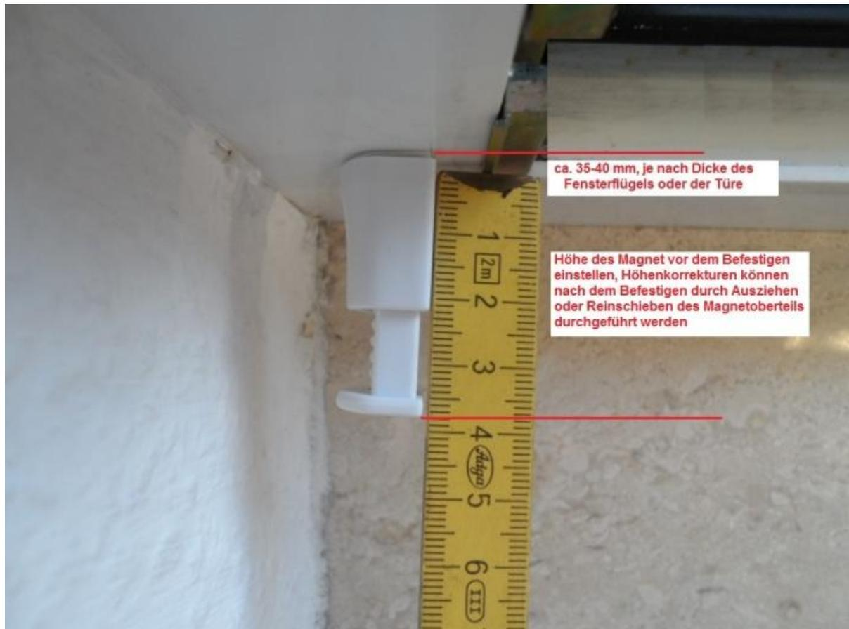
Der Magnet befindet sich im Kopf der Halterung. Sie können die notwendige Höhe durch Rausziehen des Oberteils aus der Halterung und durch Ankleben des mitgelieferten Distanzstückes einstellen.
